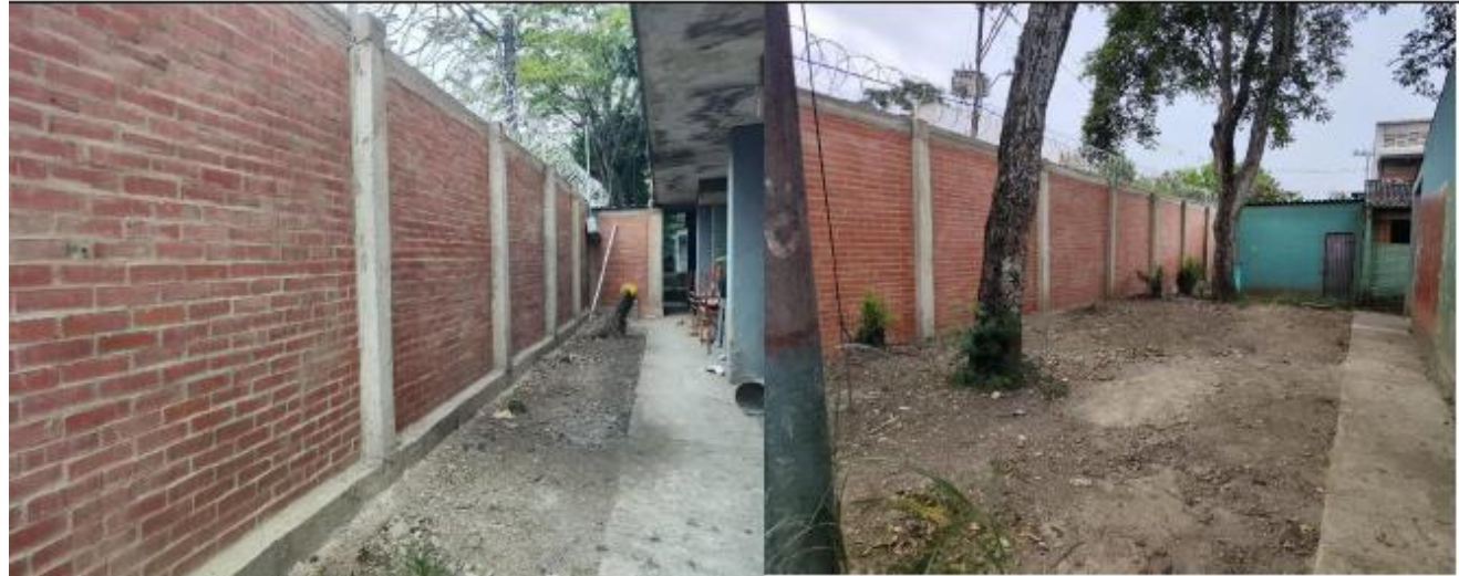
MURO LADRILLO REVITADO
